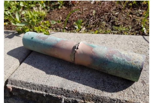
Bilden visar röret med den svetsade skarv som gått sönder. Röret är av koppar och har en diameter på 54 mm.
